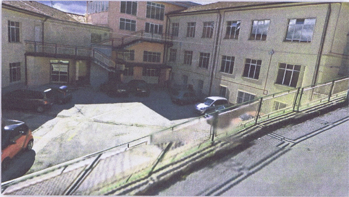
vista del cortile interno da via S. d'Acquisto (prospetti D - E)
