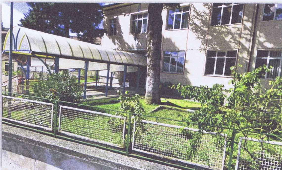
vista dell'ingresso principale di via D. Galante (prospetto A)
