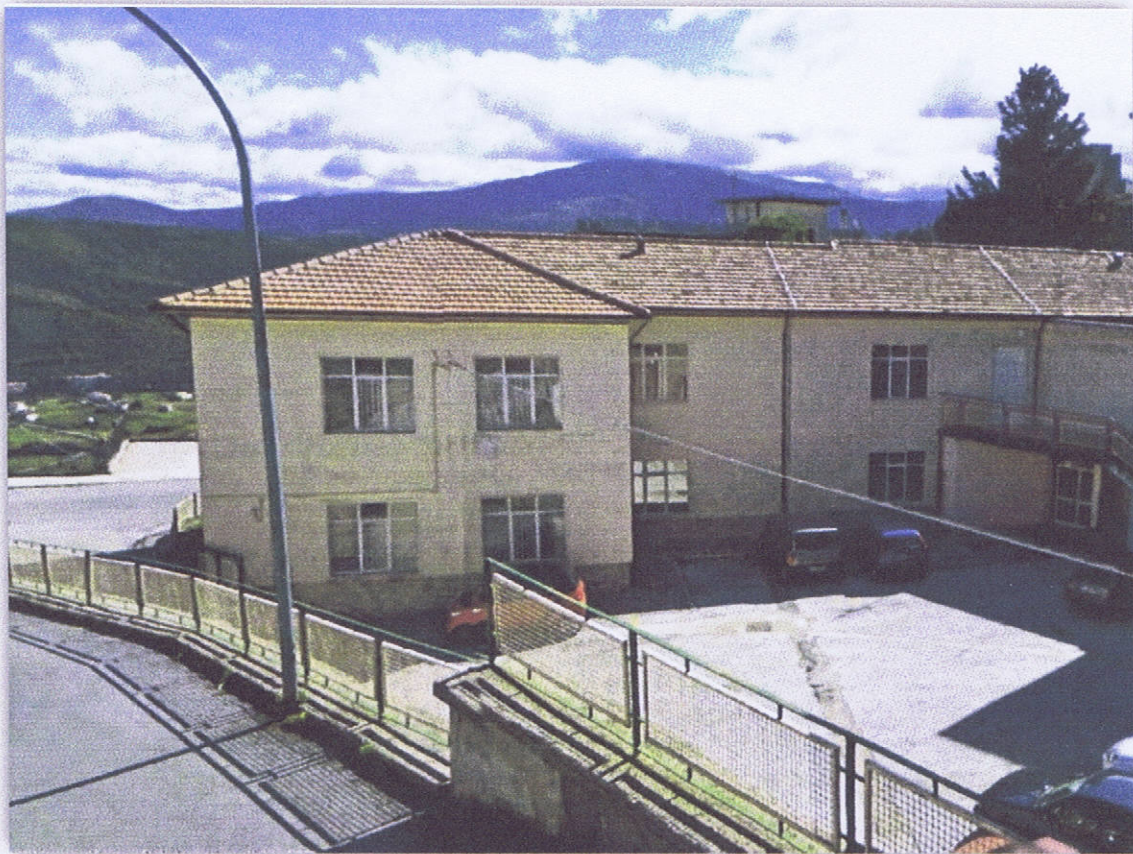
vista del cortile interno da via S. d'Acquisto (prospetto C)
